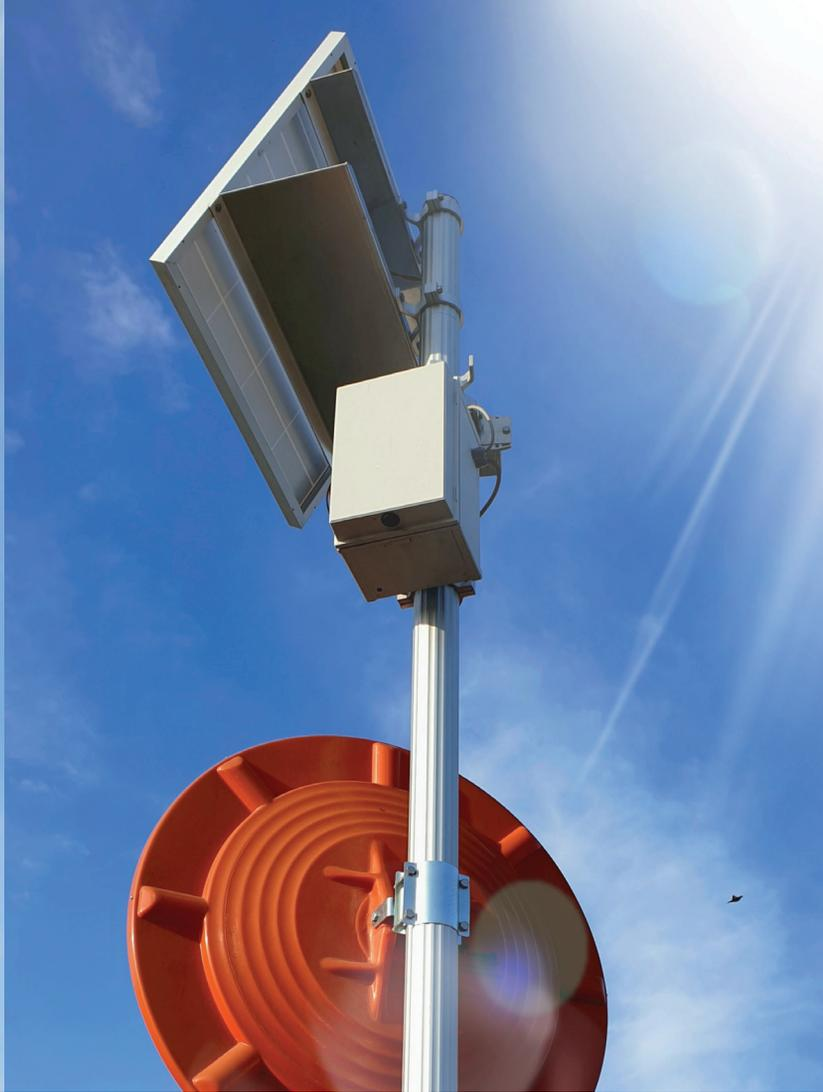
Una vez realizada la prueba piloto, se identificaron los requisitos que debía tener la señal para la consecución del objetivo. Dicho sistema pasó de ser una señal con una instalación mediante obra civil y corte de la vía para el montaje de las espiras magnéticas, a una señal totalmente novedosa, con unos elementos tecnológicos de última generación y totalmente autónoma gracias al panel solar que incorpora en la copa del mástil.
