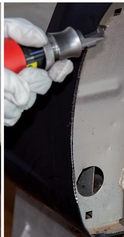
*Fresado del engatillado en un pase de ruedas.*
