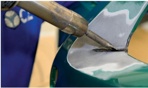
**5** Soldadura/punteado de la base de la grieta sin aportación de material, para alinear superficies.
