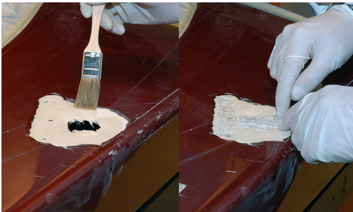
Reparación de materiales compuestos con resina de poliéster y fibra de vidrio.
