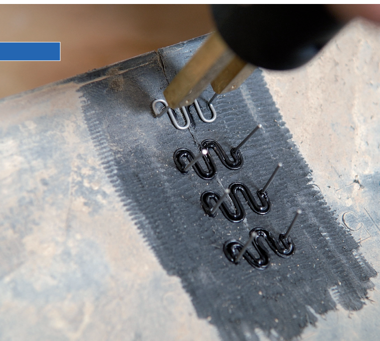
Reparación de grieta con grapas metálicas.
