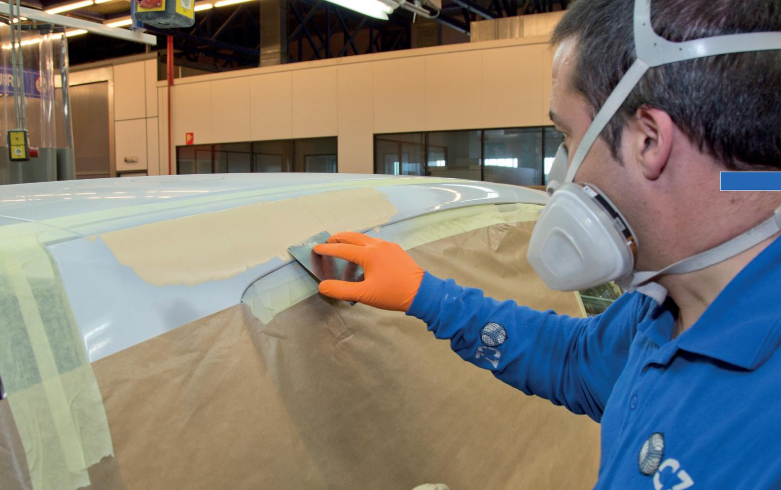
Las cualidades que se buscan en las masillas son: buena adherencia sobre el sustrato, gran poder de relleno sin mermar tras el secado, facilidad y rapidez en la preparación, aplicación y lijado, ausencia de poros y cierta flexibilidad para evitar desprendimientos y agrietamientos.
