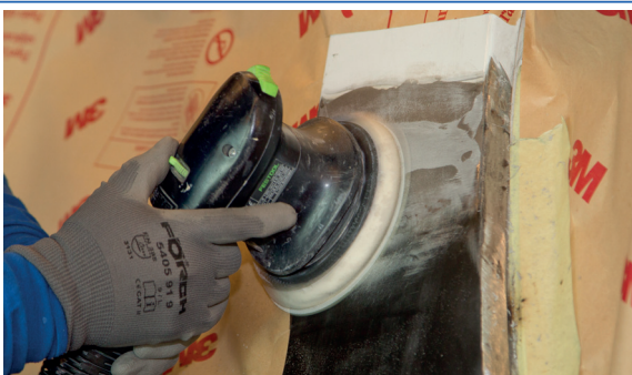
9 Lijado con lijadora roto orbital.
