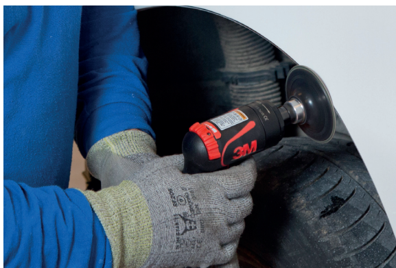
Esmerilado del engatillado del pase de ruedas con la amoladora angular.
