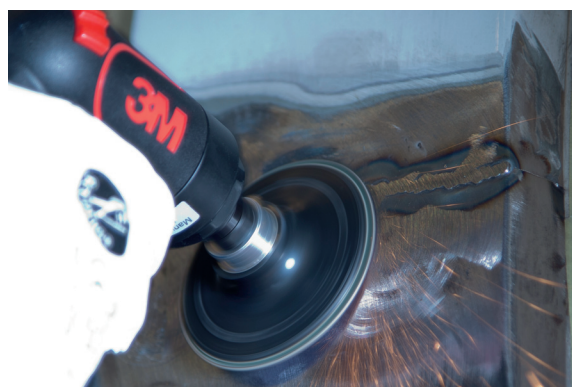
Esmerilado de la costura de soldadura con la amoladora angular.
