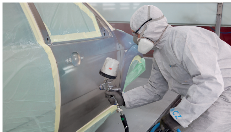
Aplicación de la resina en la zona a difuminar.
