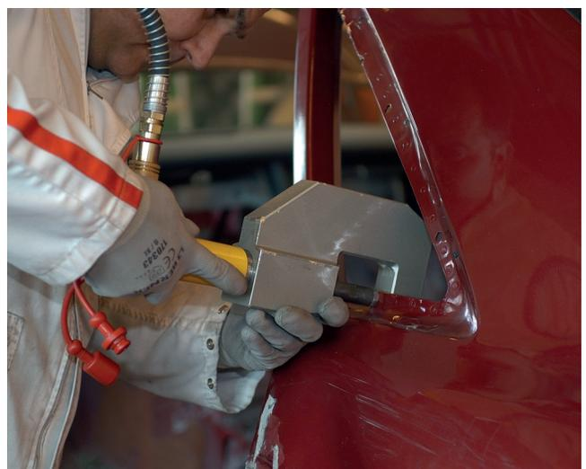
*En las carrocerías de aluminio se utiliza frecuentemente el remache junto con adhesivo.*
