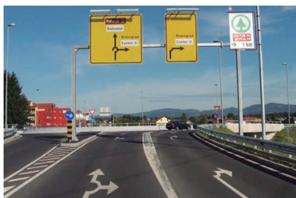
Señalización horizontal y vertical utilizada en las “turbo rotondas”.
