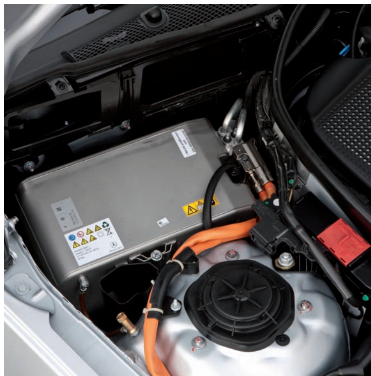
Detalle unidad de alto voltaje del sistema híbrido.
