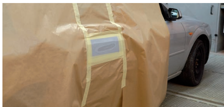
Enmascarado incorrecto para la aplicación de aparejo.
