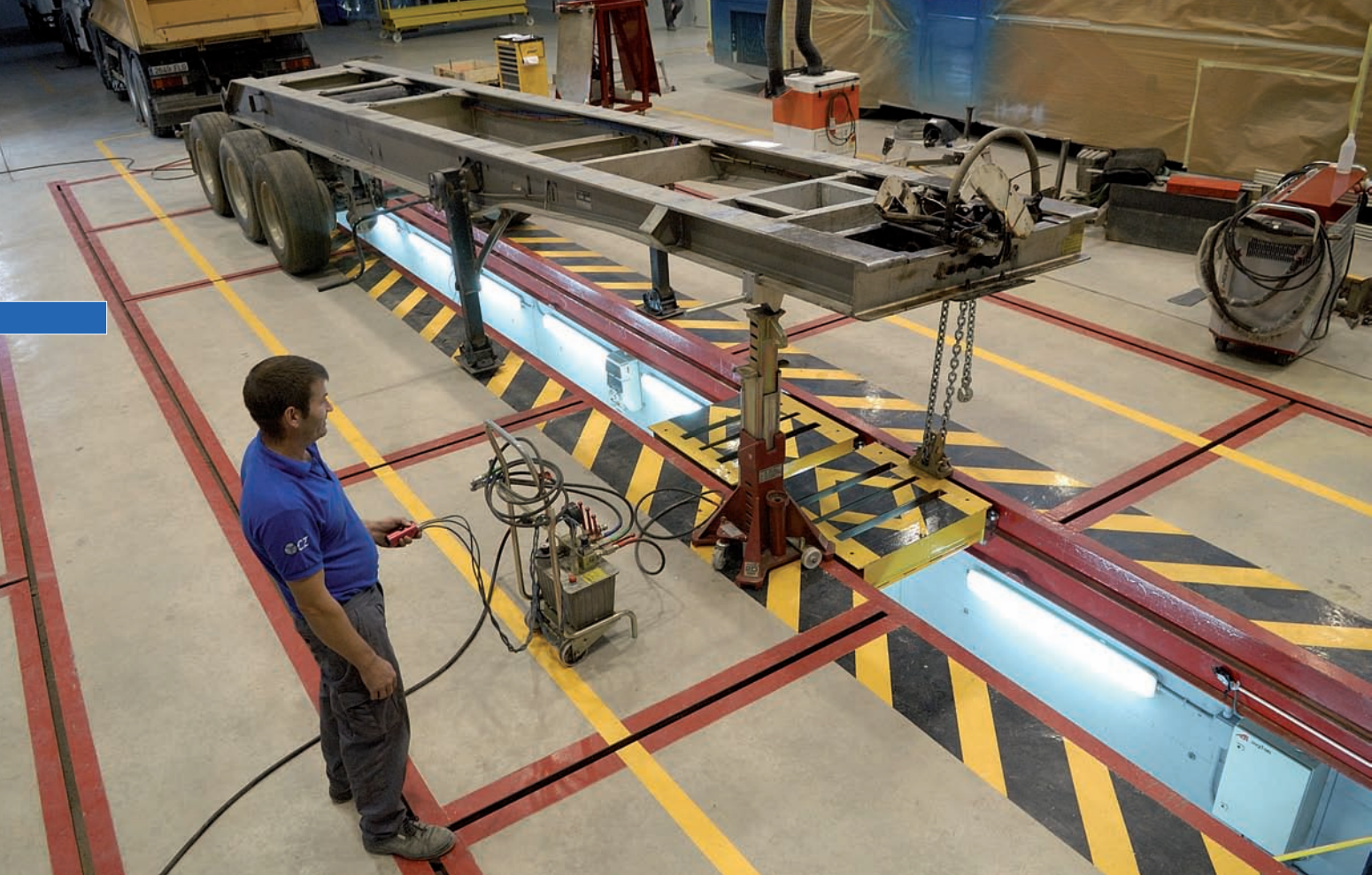
Bancada de suelo para la reparación de bastidores, con foso de servicio.
