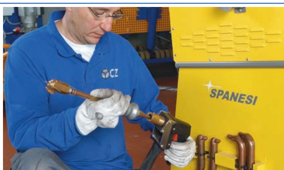
3 Instalación del martillo de inercia en la pistola de soldeo.
