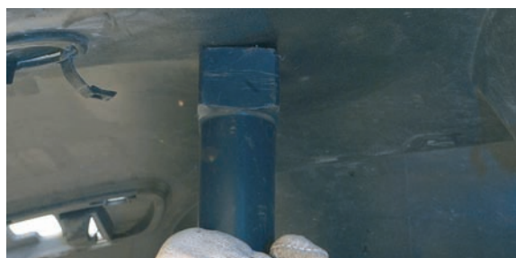
Reparación de deformación.
