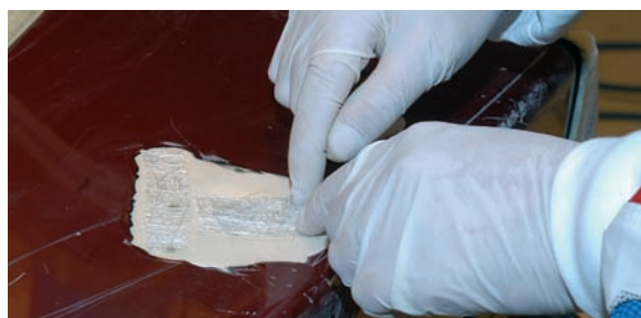
Reparación de grieta en material compuesto.
