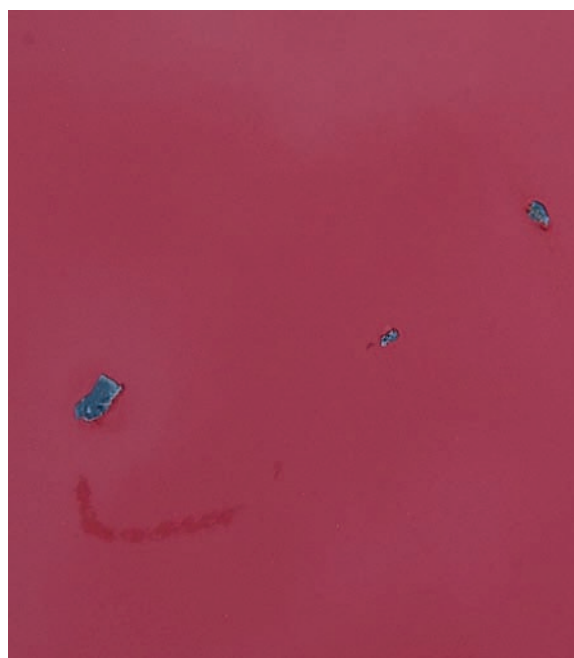
Impactos de piedra y gravilla.
