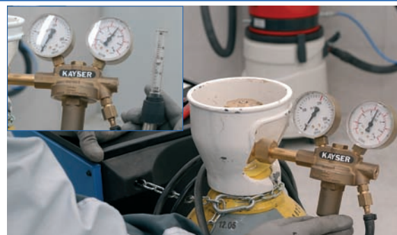
6 Comprobación de los contactos y el manorreductor.
