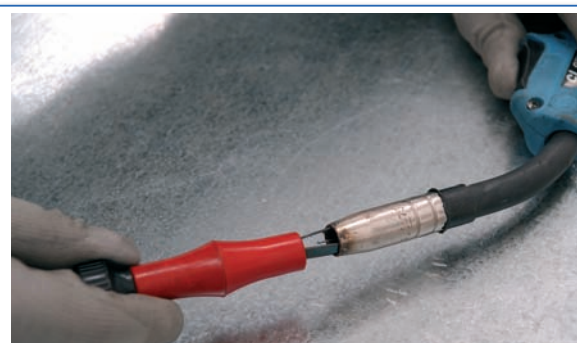
2 Revisión de tobera de gas y eliminación de proyecciones.
