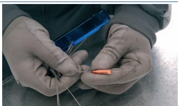
3 Revisión y limpieza de punta de contacto con escariadores calibrados.
