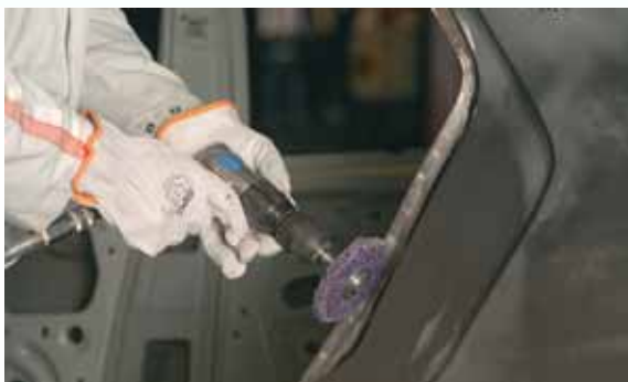
1 Limpiar las superficies a soldar de contaminantes, pinturas, grasas, etc.
