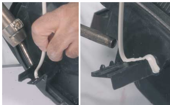
8 Aplicación del cordón de soldadura, uno por el lado interior y otro por el lado exterior, con el fin de reforzar la unión y dar resistencia a la patilla.
