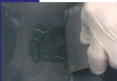
APLICACIÓN DE ADHESIVO POR EL INTERIOR
