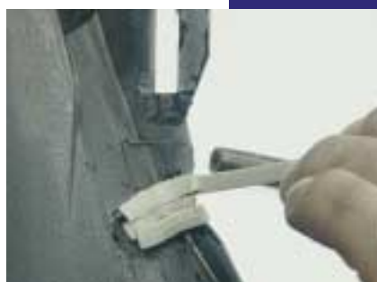
APLICACIÓN DE CORDÓN DE SOLDADURA POR EL INTERIOR
