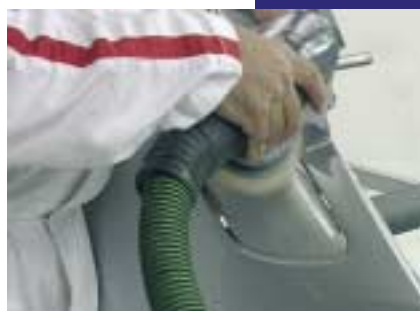
LIJADO DEL CORDÓN DE SOLDADURA
