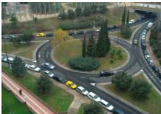
LAS ISLETAS DEFLECTORAS CONTRIBUYEN AL CORRECTO FUNCIONAMIENTO DE LAS ROTONDAS
