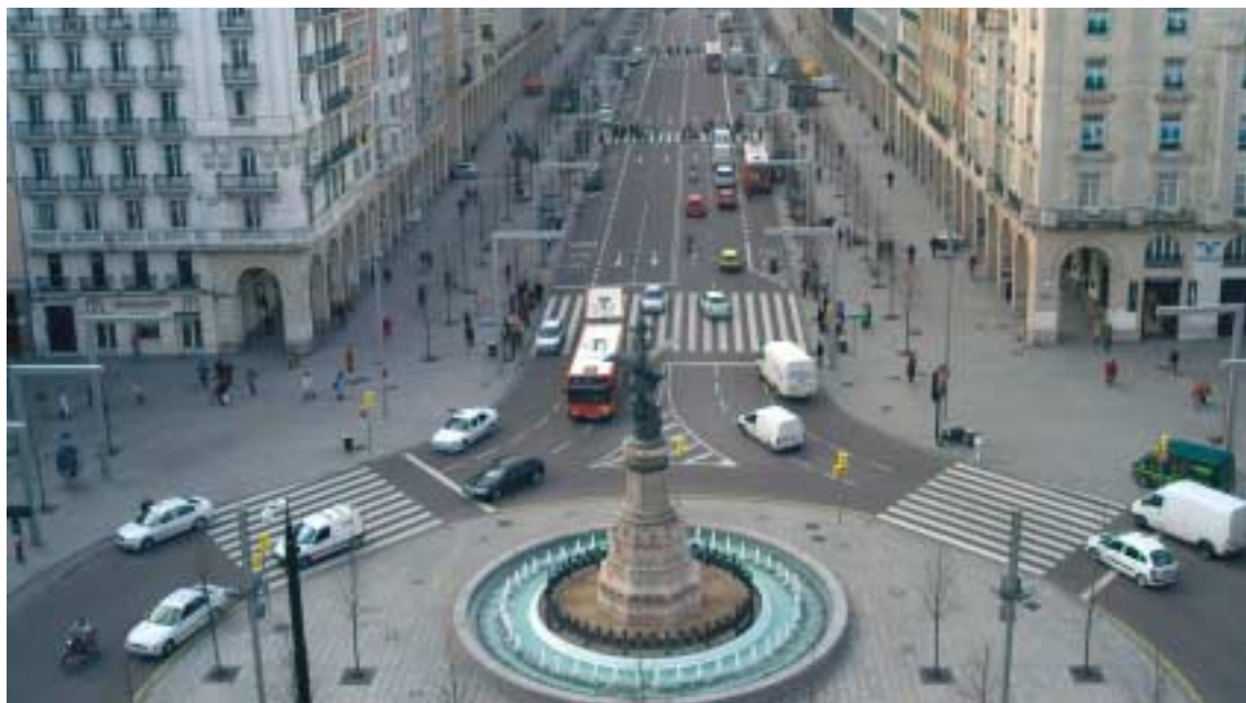
EN UN ENTORNO URBANO UNA ROTONDA DEBE CONTRIBUIR A LA MEJORA DEL PAISAJE
