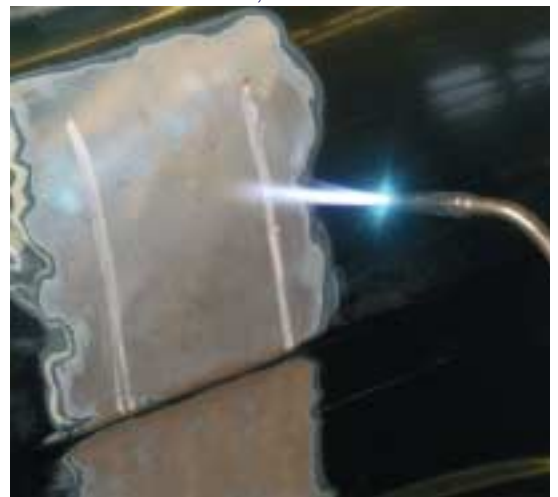
CONTRACCIÓN DE UN SOBREESTIRAMIENTO DE CHAPA INTENSO, CON EL SOPLETE OXIACETILÉNICO
