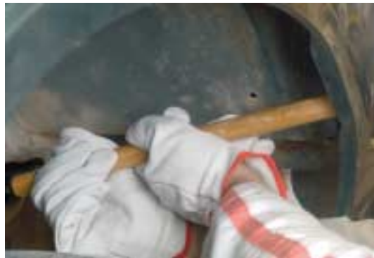
EXTRACCIÓN DE LA ABOLLADURA MEDIANTE PRESIÓN
