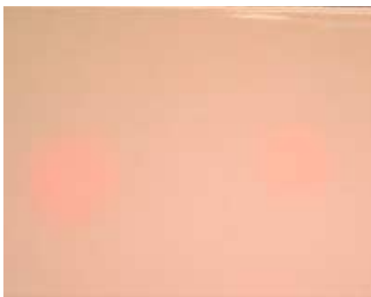
Sangrados provocados por un exceso de catalizador en la preparación de la masilla
