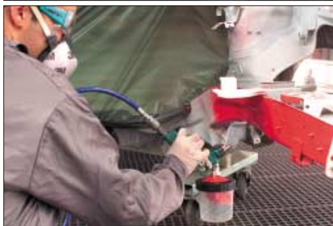
APLICACIÓN DE LA PINTURA EN ZONAS DE DIFÍCIL ACCESO.
